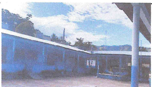
Foto 3 sustitución de canales en toda el área remozada.
