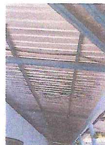
Foto 2: sustitución de láminas de corredores.
