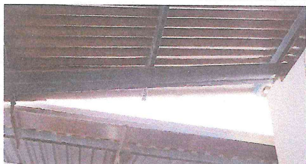
Foto 5: sustitución de canales.
