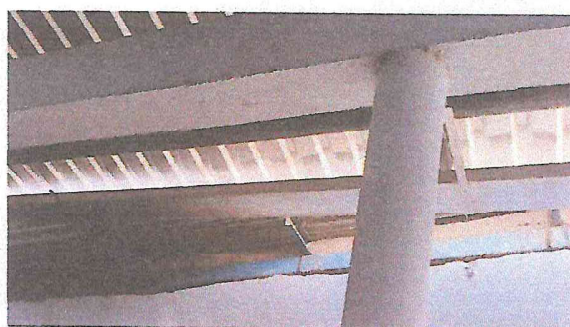
Foto 4: sustitución de canales dañados.
