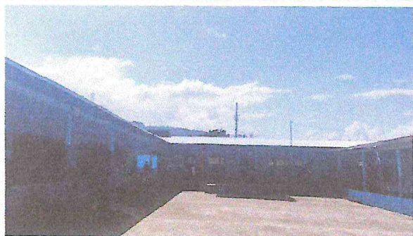
Foto1: trabajo final sustitución de lámina troquelada calibre 26.
